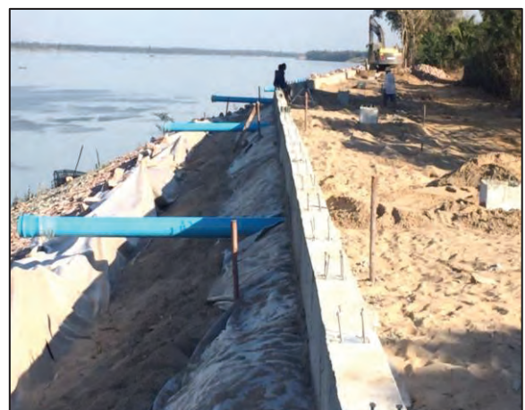
รูปที่ ๔.๒๘ งานวางท่อ พร้อมติดตั้งบ่อพัก
