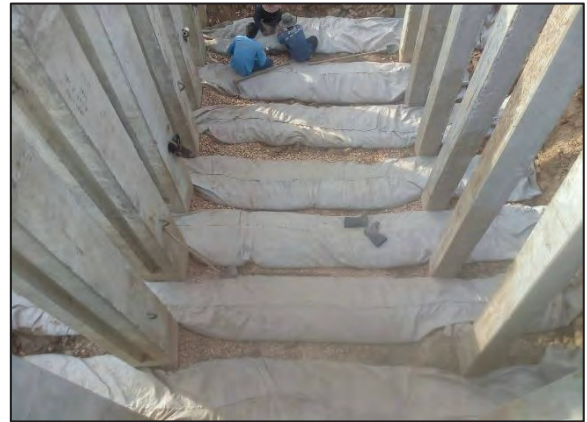
รูปที่ ๒.๓๒.๕ รางกวดที่ก่อสร้างเสร็จเรียบร้อย
