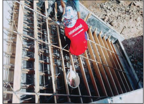
รูปที่ ๔.๑๐ เหล็กลูกตั้ง ลูกนอน
