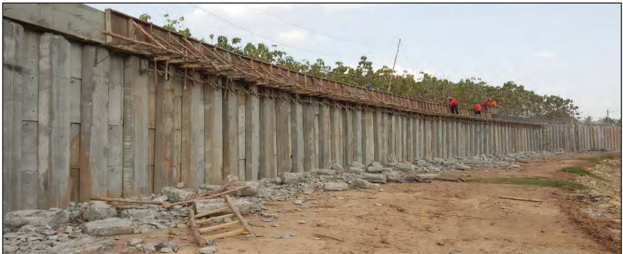
รูปที่ ๔.๖ การติดตั้งนั่งร้าน
