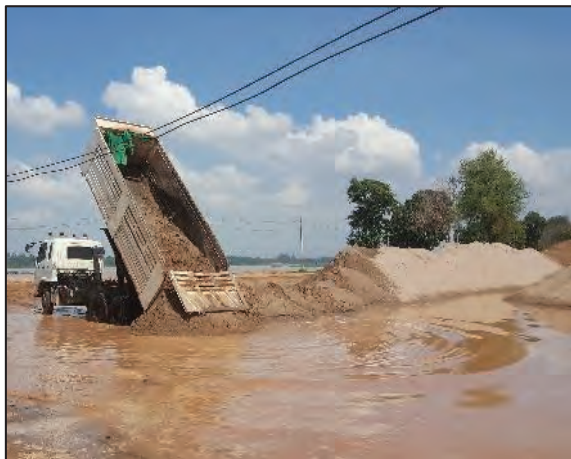
รูปที่ ๔.๔๖ รูปแสดงการนำทรายเข้ากอง
