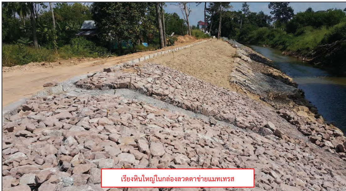
รูปที่ ๒.๔๘ งานก่อสร้างหินบรรจุร่องแมทเทรตปิดหน้าเขื่อน
