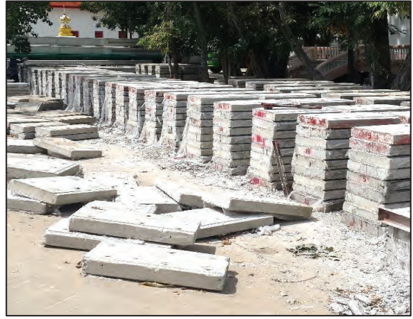
รูปที่ ๔.๖๑ รูปแสดง หล่อแผงกรู ค.ส.ล.
