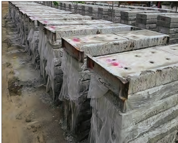
รูปที่ ๔.๖๒ รูปแสดง งานหล่อแผงกรู ค.ส.ล.
