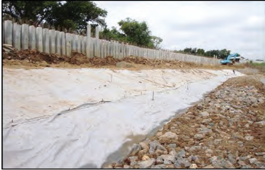
รูปที่ ๔.๕๕ รูปแสดงงานปูแผ่นใยสังเคราะห์ (วัสดุกรอง) บริเวณหน้าเขื่อน ๔.๙.๒ งานแผ่นใยสังเคราะห์ หลังเขื่อน
