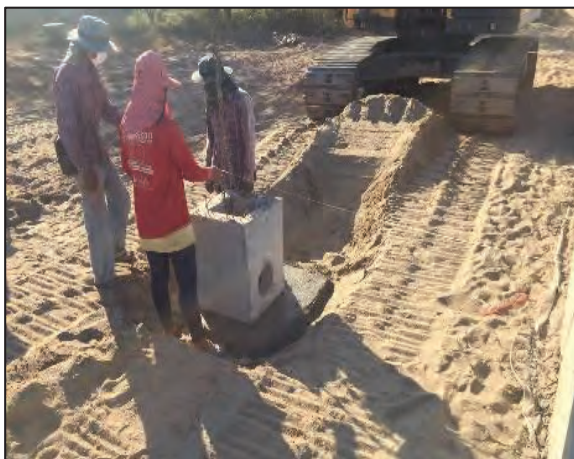
รูปที่ ๔.๒๘ งานวางท่อ พร้อมติดตั้งบ่อพัก
