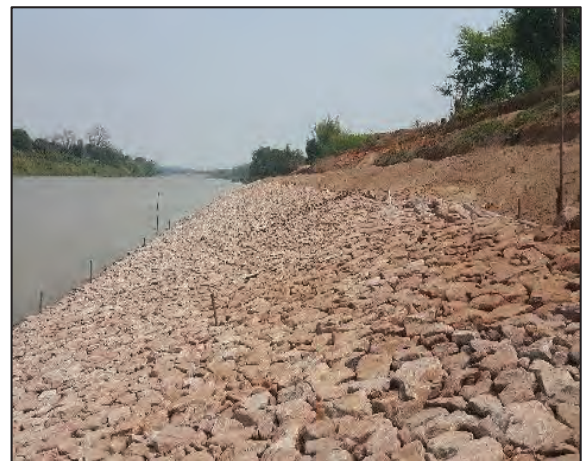
รูปที่ ๔.๔๓ รูปแสดงการนำหินจากกองไปเรียงหน้าเขื่อน
