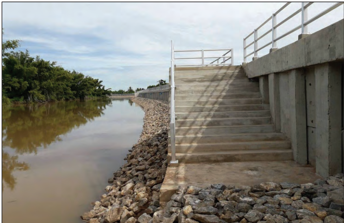
รูปที่ ๒.๒๒ บันไดลงข้างเขื่อน
