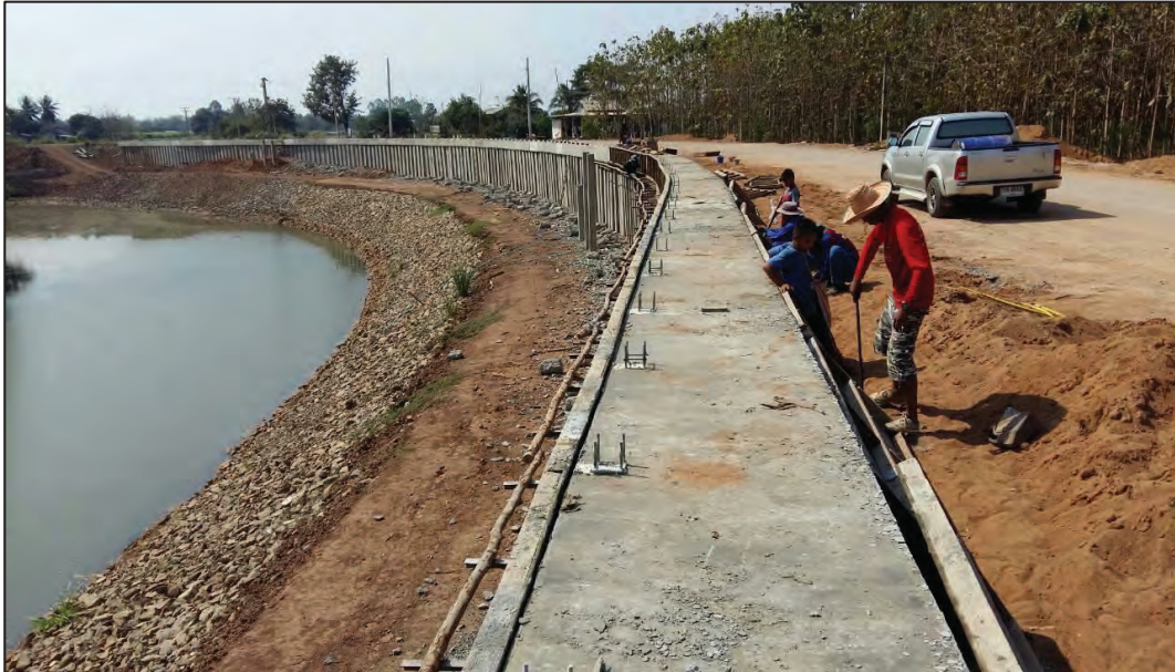
รูปที่ ๔.๘ การถอดแบบข้างคานรัดหัวเสาเข็ม
