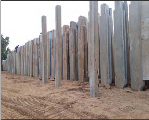
รูปที่ ๒.๑๕ การตอกเสาเข็มรับโครงสร้างบันไดหน้าเขื่อน
