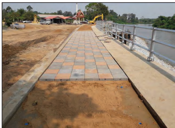
รูปที่ ๒.๒๘.๒ ปูทรายก่อนวางบล็อกคอนกรีต
