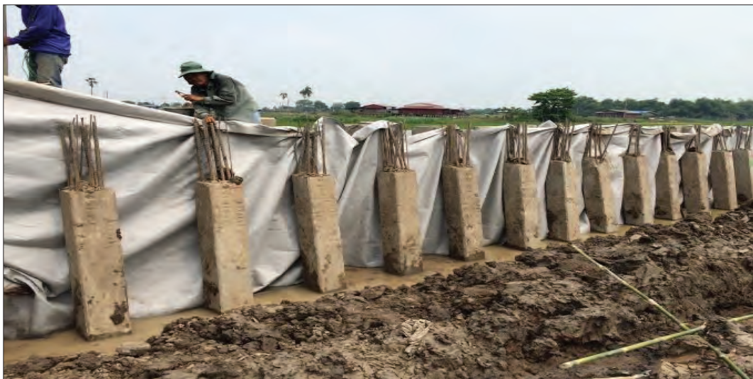
รูปที่ ๔.๕๗ รูปแสดงปูแผ่นใยสังเคราะห์ (วัสดุกรอง) หลังเขื่อน
