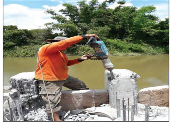
รูปที่ ๔.๕ เมื่อทำการตัดขอบรอบเสาเข็มแล้วเสร็จ จึงดำเนินการสกัดหัวเสาเข็ม
