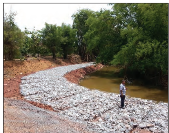
รูปที่ ๒.๔๗.๒ การนำล่องมาเรียงจึงง่ายแก่การตรวจสอบ
