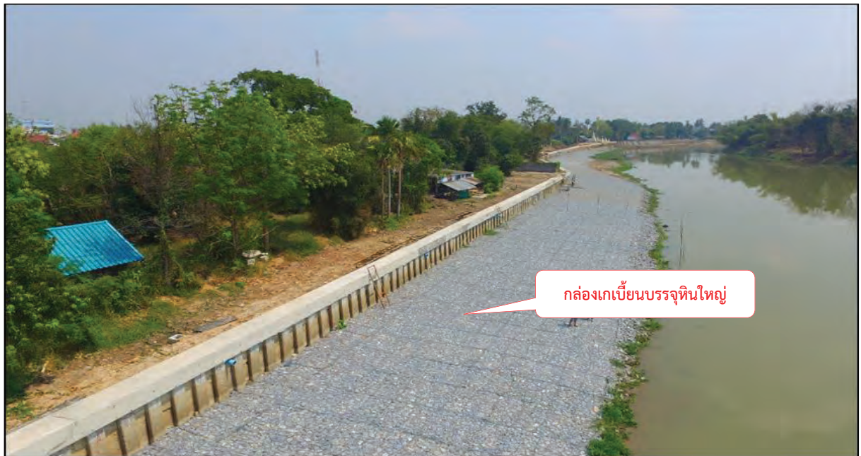
รูปที่ ๔.๗๑ รูปแสดง งานกล่องลวดตาข่ายเกเบียงบรรจุหินใหญ่หน้าเขื่อน
