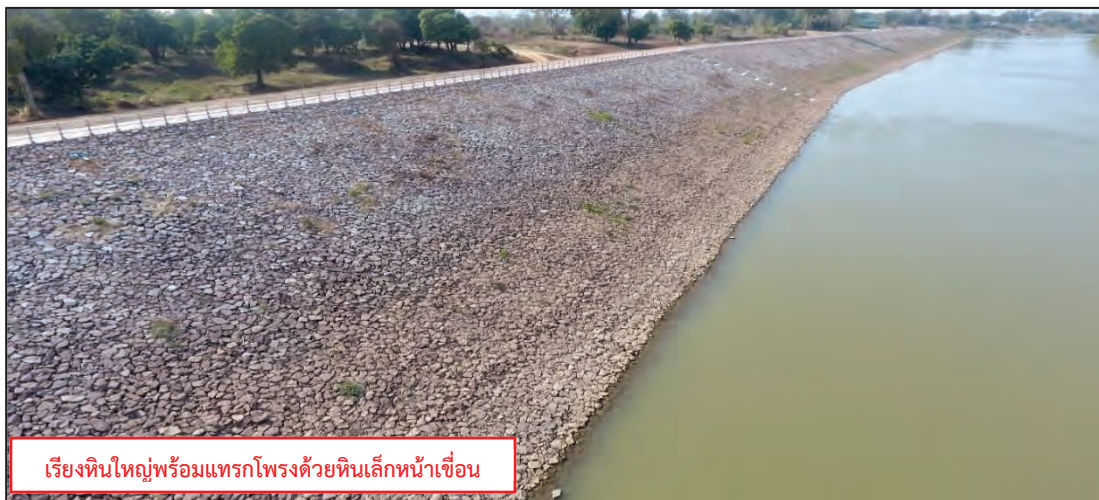
รูปที่ ๒.๓๔ เรียงหินใหญ่พร้อมแทรกโพรงด้วยหินเล็กหน้าเขื่อน
