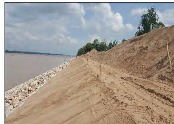
รูปที่ ๔.๔๙ รูปแสดงการนำทรายถมจากกองไปบดอัดบริเวณเขื่อน
