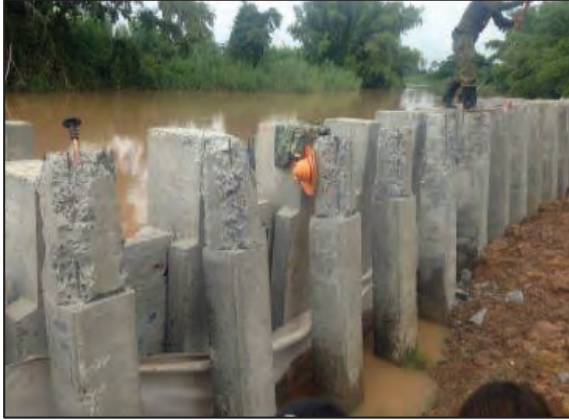
รูปที่ ๔.๕ เมื่อทำการตัดขอบรอบเสาเข็มแล้วเสร็จ จึงดำเนินการสกัดหัวเสาเข็ม
