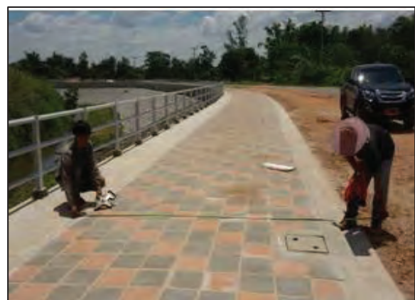
รูปที่ ๒.๒๘.๓ วางบล็อกคอนกรีตเต็มแผ่น (ห้ามตัด)
