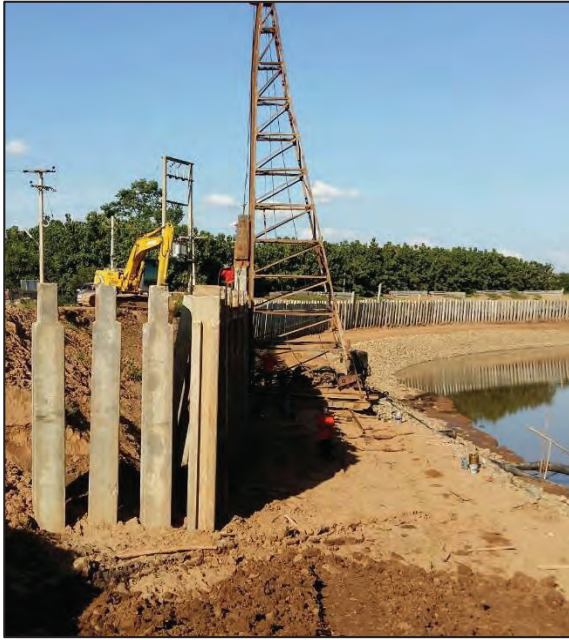
รูปที่ ๔.๒ ปรับพื้นที่ตอกเสาเข็มหน้าเขื่อน
