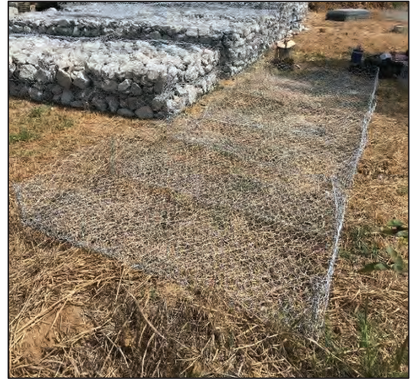
รูปที่ ๔.๖๘ รูปแสดงนำร่องลวดตาข่ายแมทเทรสมาประกอบและบรรจุหินใหญ่
