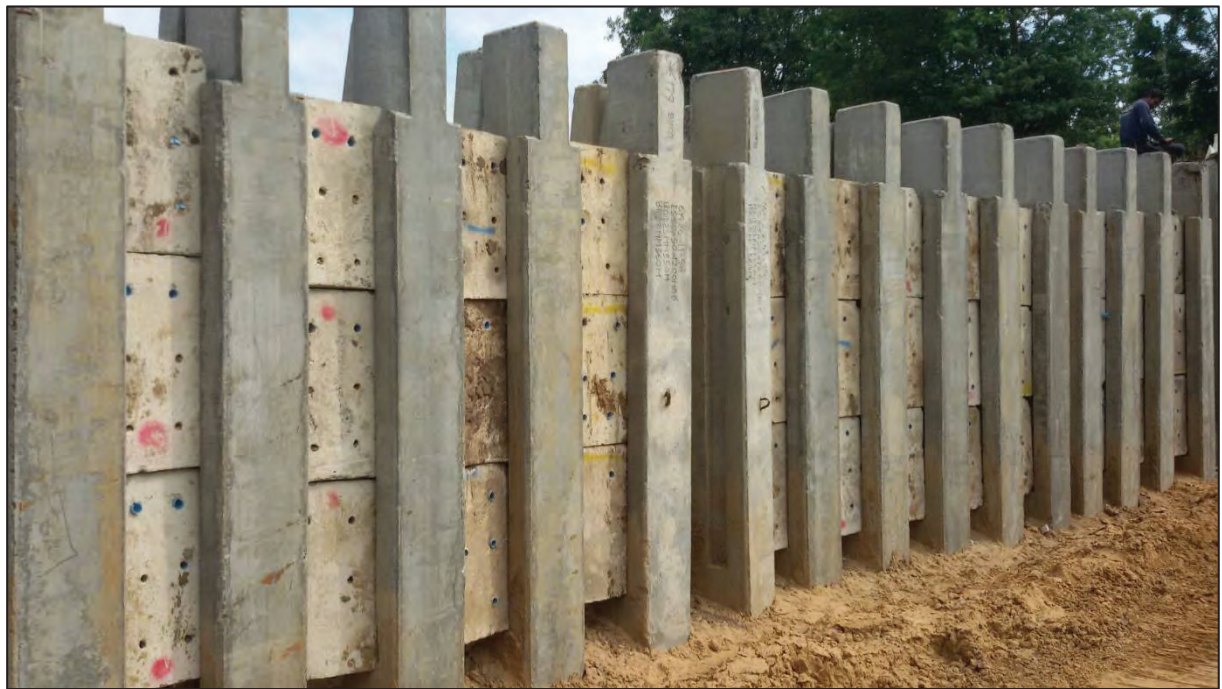
รูปที่ ๒.๔๕ การเสียบแผงกรู ค.ส.ล. ระหว่างเสาเข็ม A
