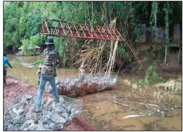
รูปที่ ๒.๔๗.๔ นำกล่องฯ เข้าวางเพื่อปิดดินเขื่อน
