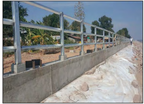
รูปที่ ๒.๒๑.๕ คาน ค.ส.ล. ที่หล่อแล้วเสร็จ
