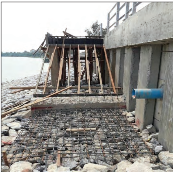
รูปที่ ๔.๑๑ เทคอนกรีตคานรับบันได
