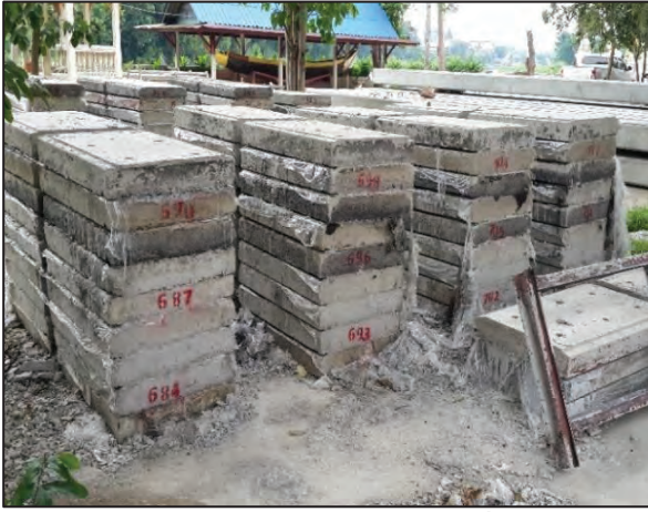
รูปที่ ๔.๖๑ รูปแสดง หล่อแผงกรู ค.ส.ล.
