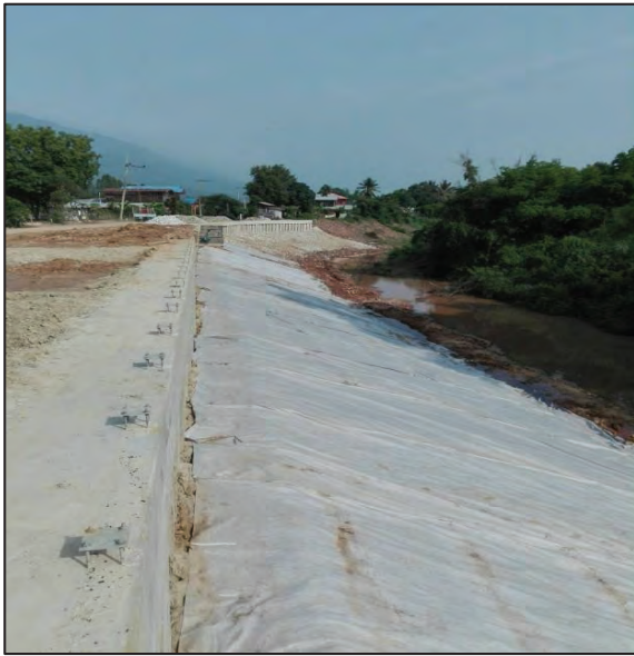
รูปที่ ๒.๔๒ การปูแผ่นใยสังเคราะห์ด้านหน้าเขื่อนฯ
