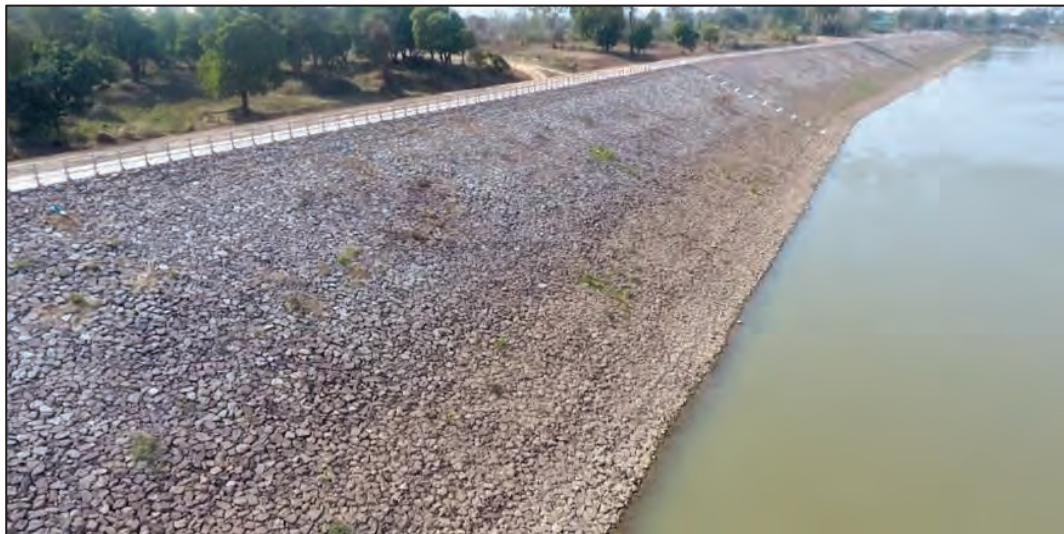
รูปที่ ๔.๔๐ รูปแสดง เรียงหินใหญ่พร้อมแทรกโพรงด้วยหินเล็กหน้าเขื่อน
