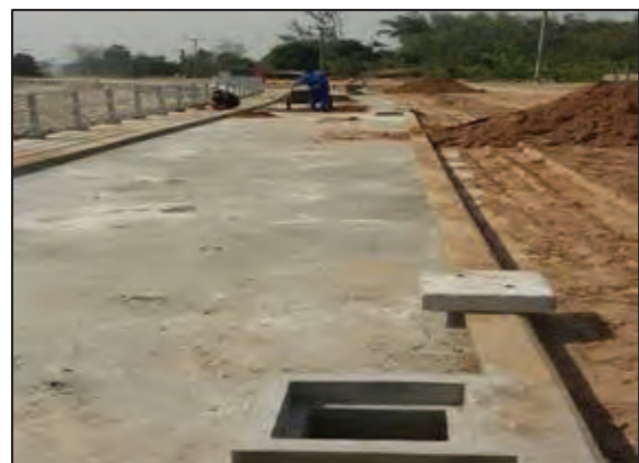
รูปที่ ๒.๒๘.๑ เทคอนกรีตหยาบแล้วเสร็จ
