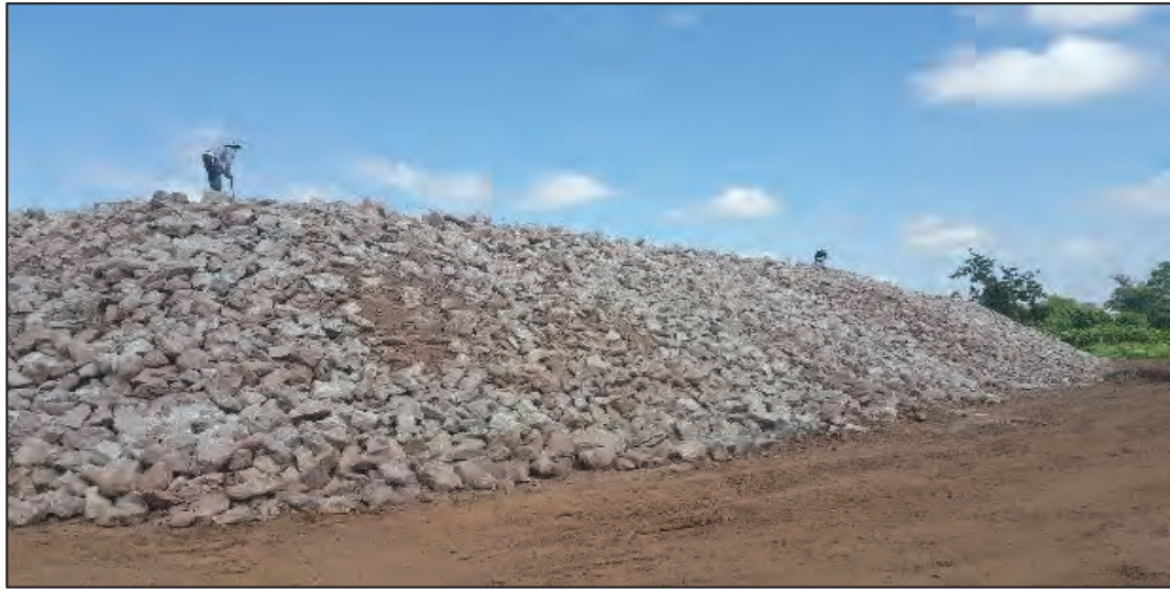
รูปที่ ๔.๔๒ รูปแสดงการนำหินเข้ากองเป็นรูปทรงเรขาคณิต
