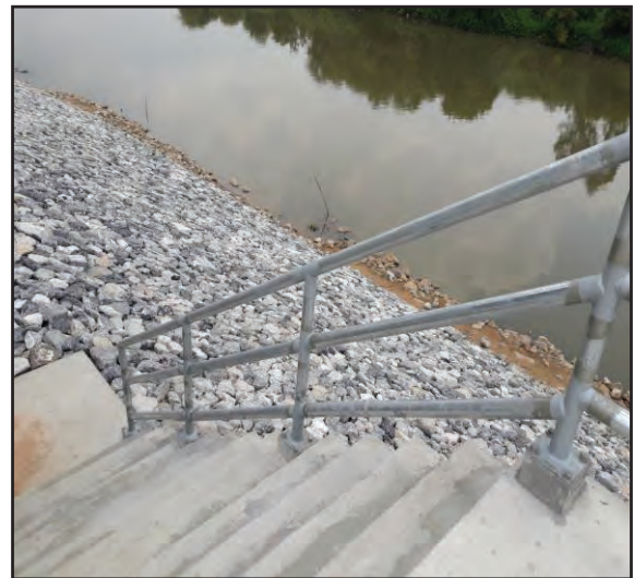
รูปที่ ๔.๑๔ ราวบันไดเป็นเหล็กกลมเพื่อการใช้งานที่ปลอดภัยยิ่งขึ้น
