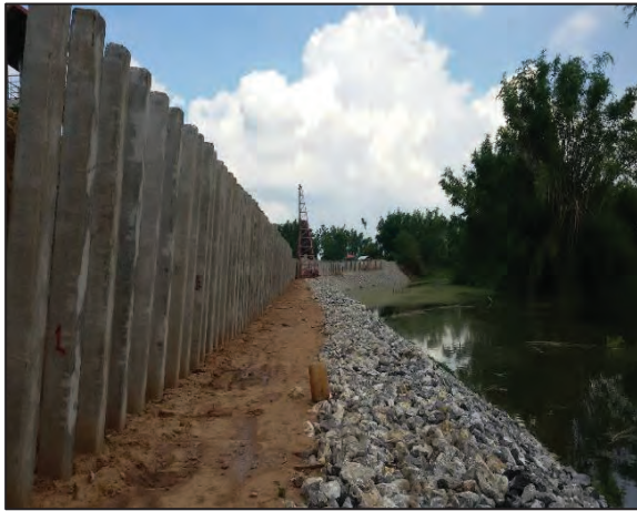
รูปที่ ๒.๑๒ ตอกเสาเข็ม B แนวเอียง Slope ๑:๖
