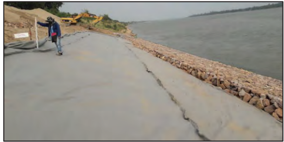
รูปที่ ๒.๔๒ การปูแผ่นใยสังเคราะห์ด้านหน้าเขื่อนฯ
