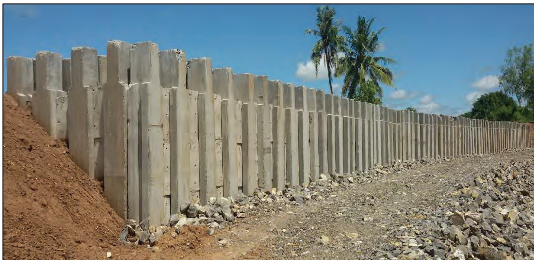
รูปที่ ๔.๔ เสาเข็ม A และ B ที่ดำเนินการตอกแล้วเสร็จ
