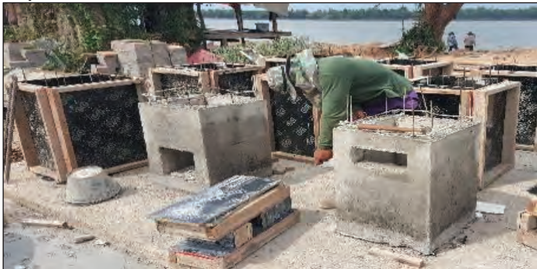
รูปที่ ๔.๒๗ งานหล่อคอนกรีตบ่อพัก
