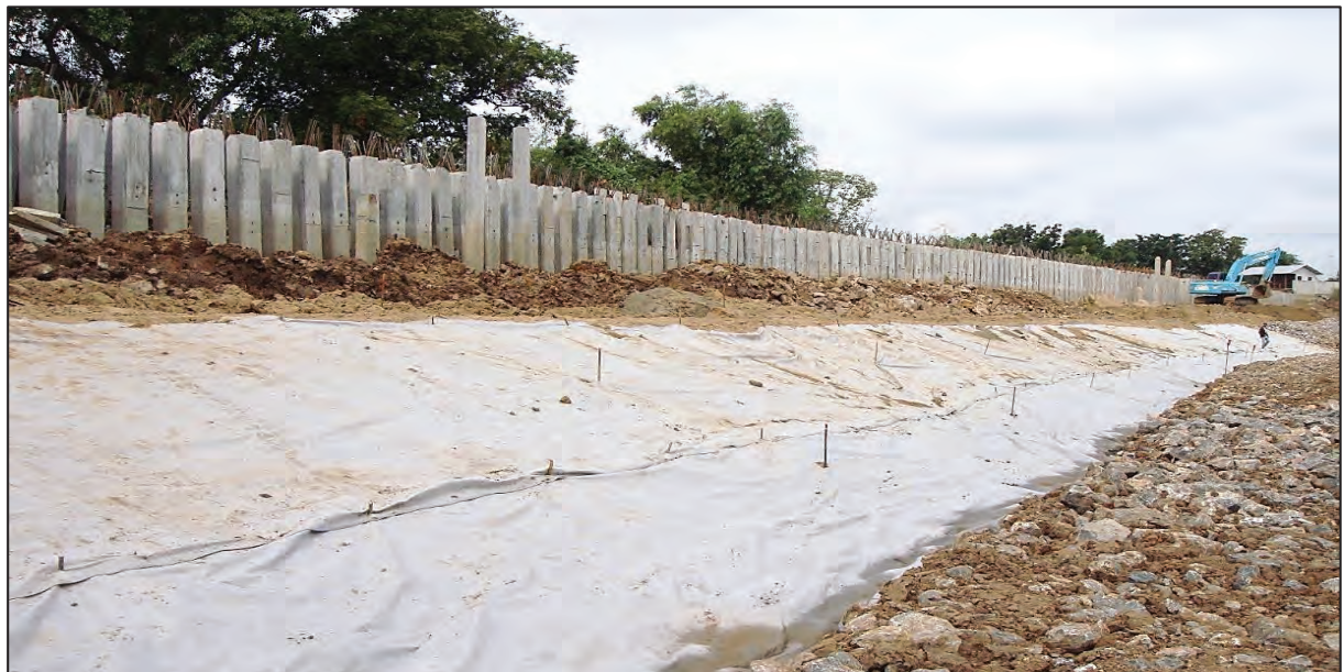
รูปที่ ๔.๕๓ รูปแสดงปูแผ่นใยสังเคราะห์ (วัสดุกรอง) หน้าเขื่อน
