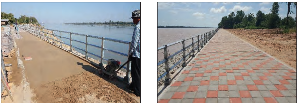
รูปที่ ๔.๒๕ งานปูแผ่นบล็อกประสาน
