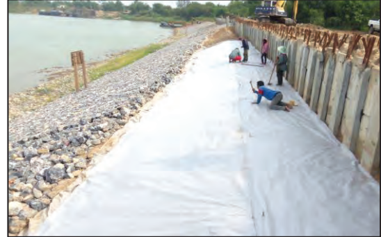
รูปที่ ๔.๕๕ รูปแสดงงานปูแผ่นใยสังเคราะห์ (วัสดุกรอง) บริเวณหน้าเขื่อน ๔.๙.๒ งานแผ่นใยสังเคราะห์ หลังเขื่อน
