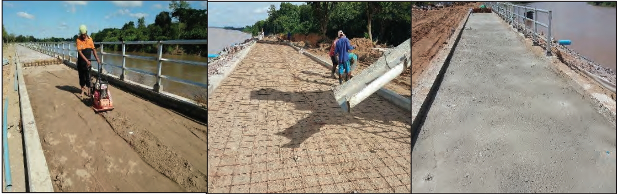
รูปที่ ๔.๒๓ งานปรับระดับทราย บดอัดทราย จัดวางตะแกรง wire mesh เทคอนกรีตหยาบ
