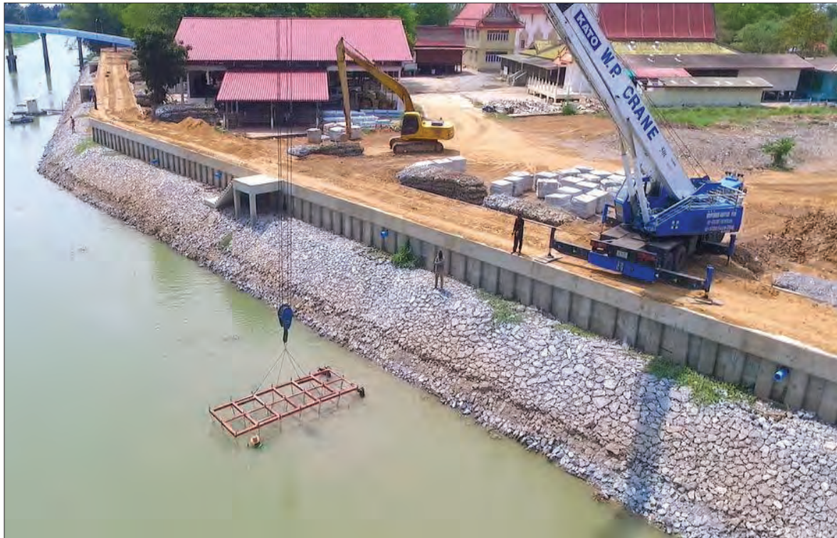
รูปที่ ๔.๖๙ รูปแสดงติดตั้งลวดตาข่ายแมทเทรสบรรจุหินใหญ่หน้าเขื่อน
