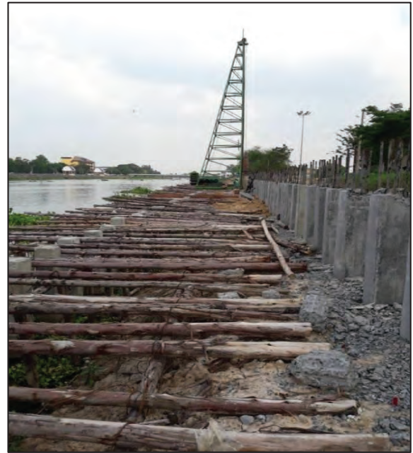
รูปที่ ๔.๓ ก่อสร้างนั่งร้านกรณีไม่มีพื้นที่หน้าเขื่อน
