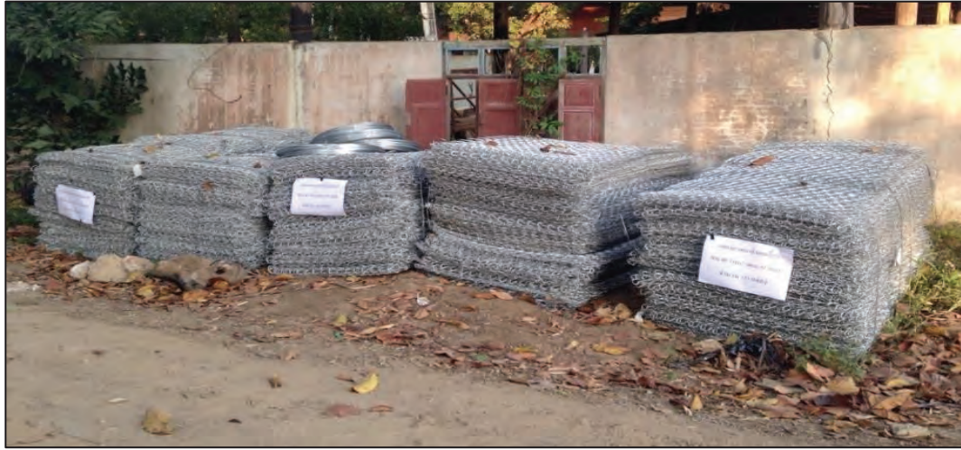
รูปที่ ๔.๗๒ รูปแสดงนำกล่องลวดตาข่ายเกเบี่ยนเข้ากองสถานที่ก่อสร้าง
