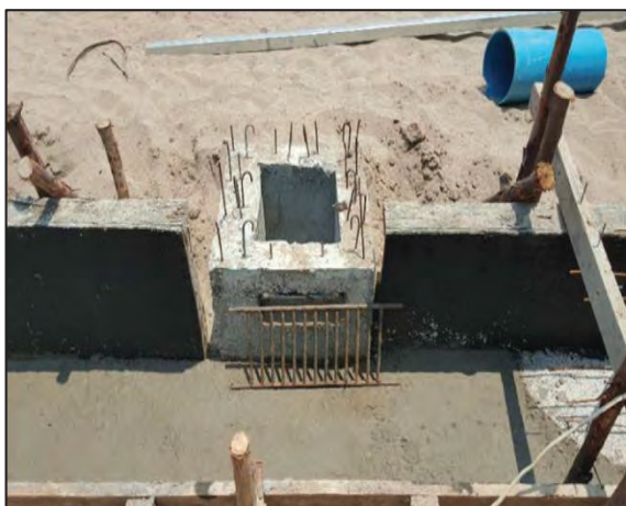
รูปที่ ๒.๒๙ บ่อพักน้ำคอนกรีตเสริมเหล็กด้านหลังเขื่อน (ทุกระยะไม่เกิน ๒๐.๐๐ เมตร)
