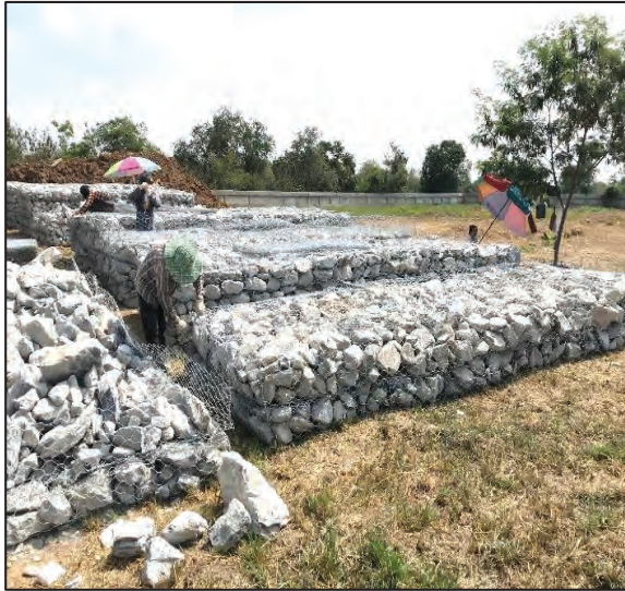
รูปที่ ๔.๖๘ รูปแสดงนำร่องลวดตาข่ายแมทเทรสมาประกอบและบรรจุหินใหญ่
