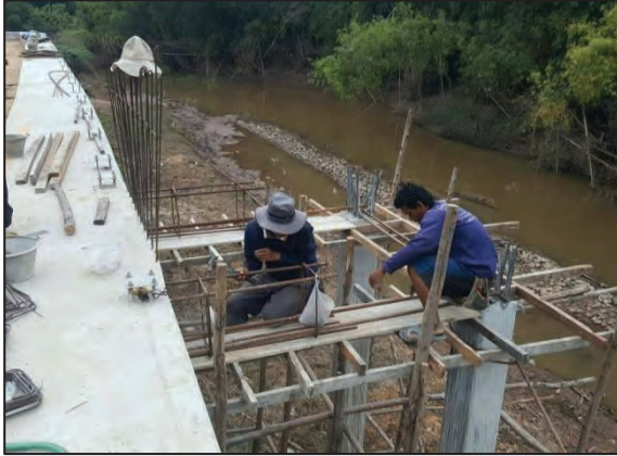
รูปที่ ๔.๙ เหล็กคานรับคานพักบันไดด้านบน
