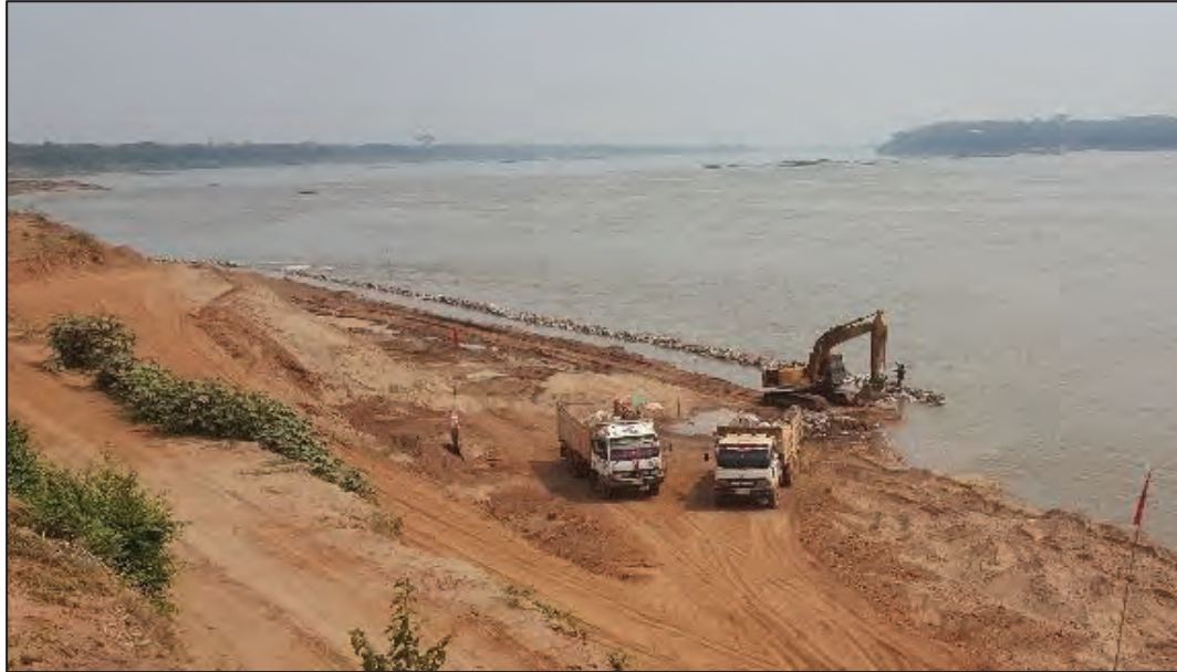
รูปที่ ๔.๓๕ รูปแสดงการนำหินเข้าแล้วนำไปทำการก่อสร้างคันหินดินเขื่อน (ทิ้งหินดินเขื่อน)
