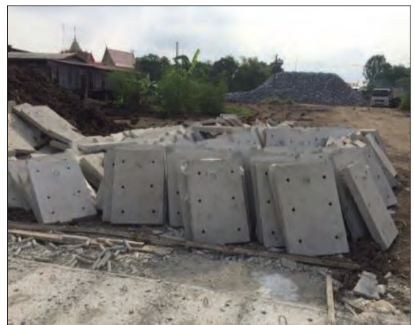
รูปที่ ๔.๖๒ รูปแสดง งานหล่อแผงกรู ค.ส.ล.
