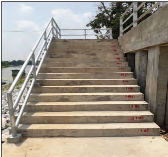
รูปที่ ๔.๑๔ ราวบันไดเป็นเหล็กกลมเพื่อการใช้งานที่ปลอดภัยยิ่งขึ้น
