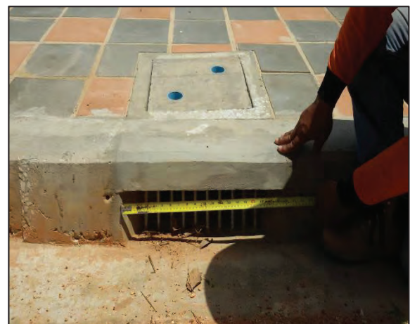
รูปที่ ๒.๒๙ บ่อพักน้ำคอนกรีตเสริมเหล็กด้านหลังเขื่อน (ทุกระยะไม่เกิน ๒๐.๐๐ เมตร)
