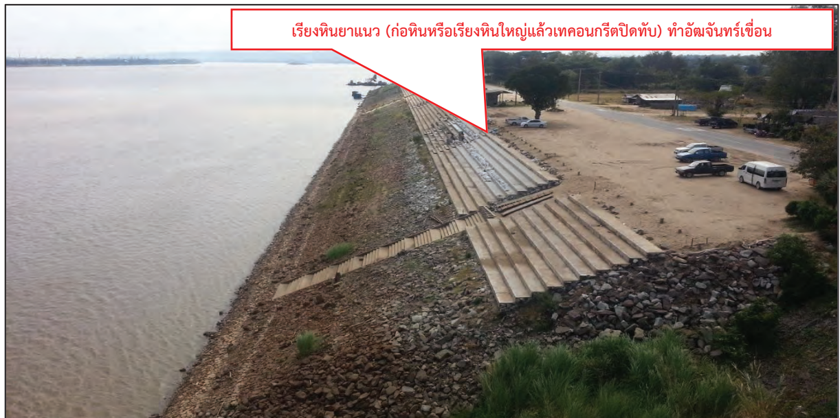
รูปที่ ๒.๓๖ เรียงหินยาแนว (ก้อนหินหรือเรียงหินใหญ่แล้วเทคอนกรีตปิดทับ) ทำอัดจันท์เชื่อม
