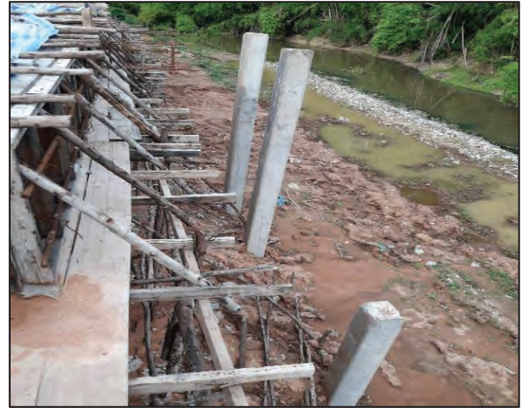
รูปที่ ๒.๑๕ การตอกเสาเข็มรับโครงสร้างบันไดหน้าเขื่อน
