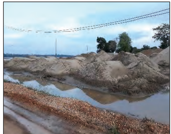
รูปที่ ๔.๔๖ รูปแสดงการนำทรายเข้ากอง
