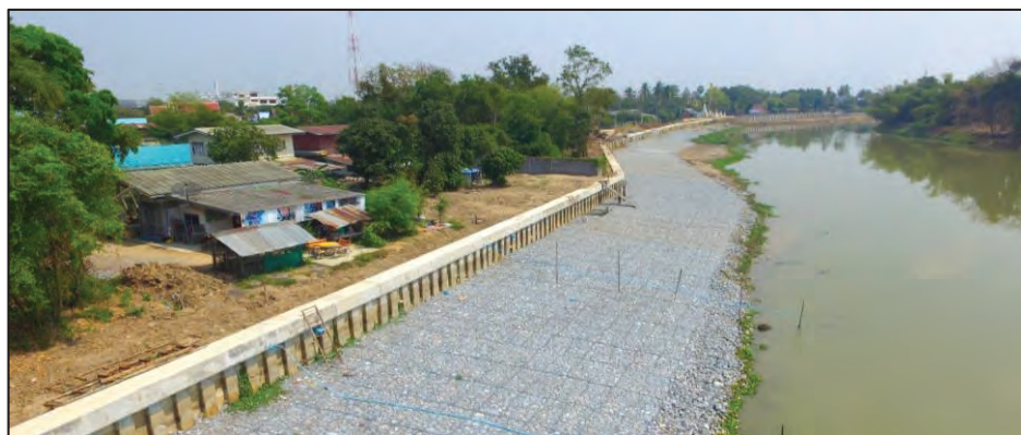
รูปที่ ๔.๗๓ รูปแสดงติดตั้งกล่องลวดตาข่ายเกเบี่ยนบรรจุหินใหญ่
