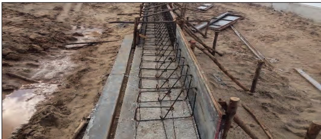
รูปที่ ๔.๒๐ งานเหล็กเสริมคันหิน
