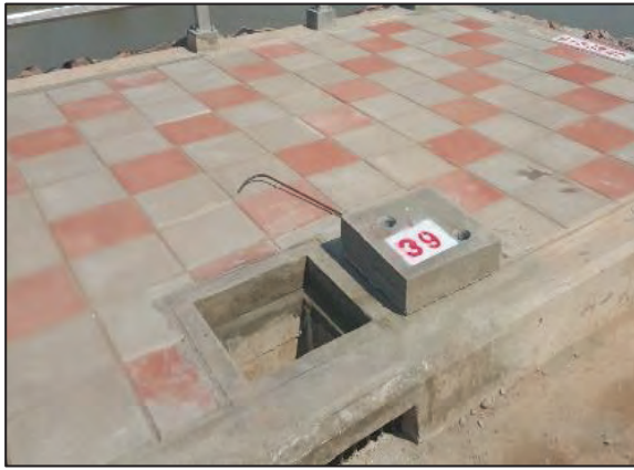
รูปที่ ๔.๒๙ งานขอบบ่อพัก ฝาบ่อ ตัดปลายท่อ
