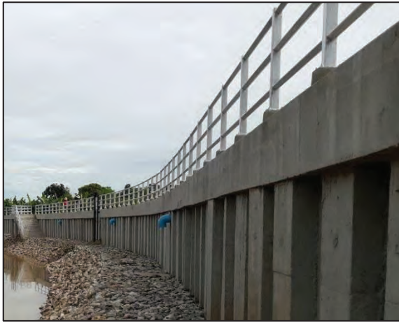
รูปที่ ๒.๑๗ คาน GB๑ อยู่ด้านหน้าเขื่อน
