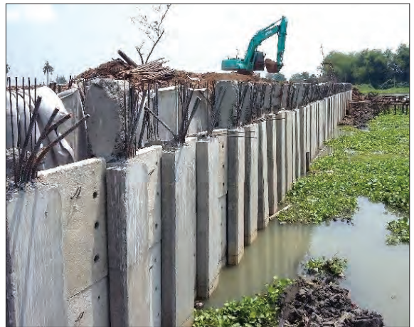
รูปที่ ๔.๖๓ รูปแสดงงานติดตั้งแผงกรู ค.ส.ล.
