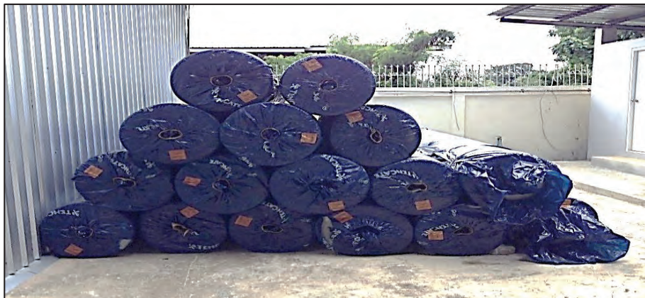
รูปที่ ๔.๕๘ รูปแสดงนำแผ่นใยสังเคราะห์ (วัสดุกรอง) เข้ากองสถานที่ก่อสร้าง
