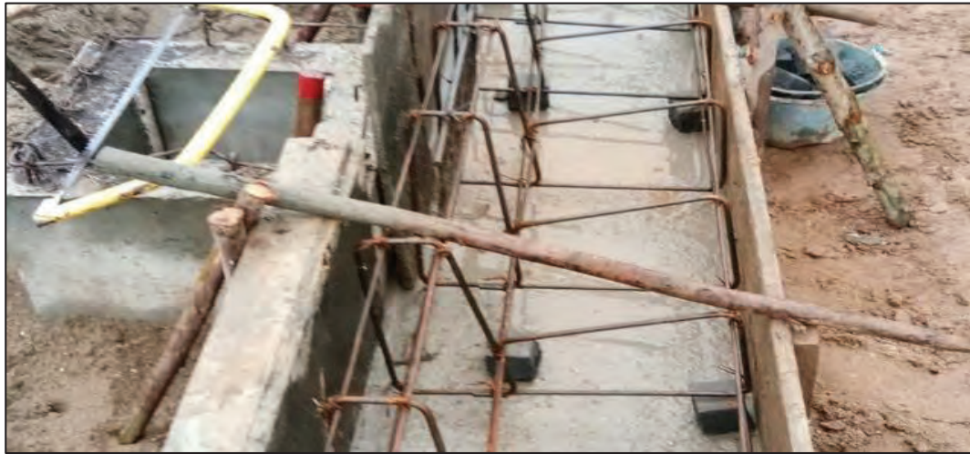
รูปที่ ๔.๒๑ งานแบบหล่อ
