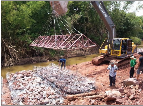
รูปที่ ๒.๔๗.๓ เริ่มยกกล่องฯ จากฝั่งเข้าติดตั้ง
