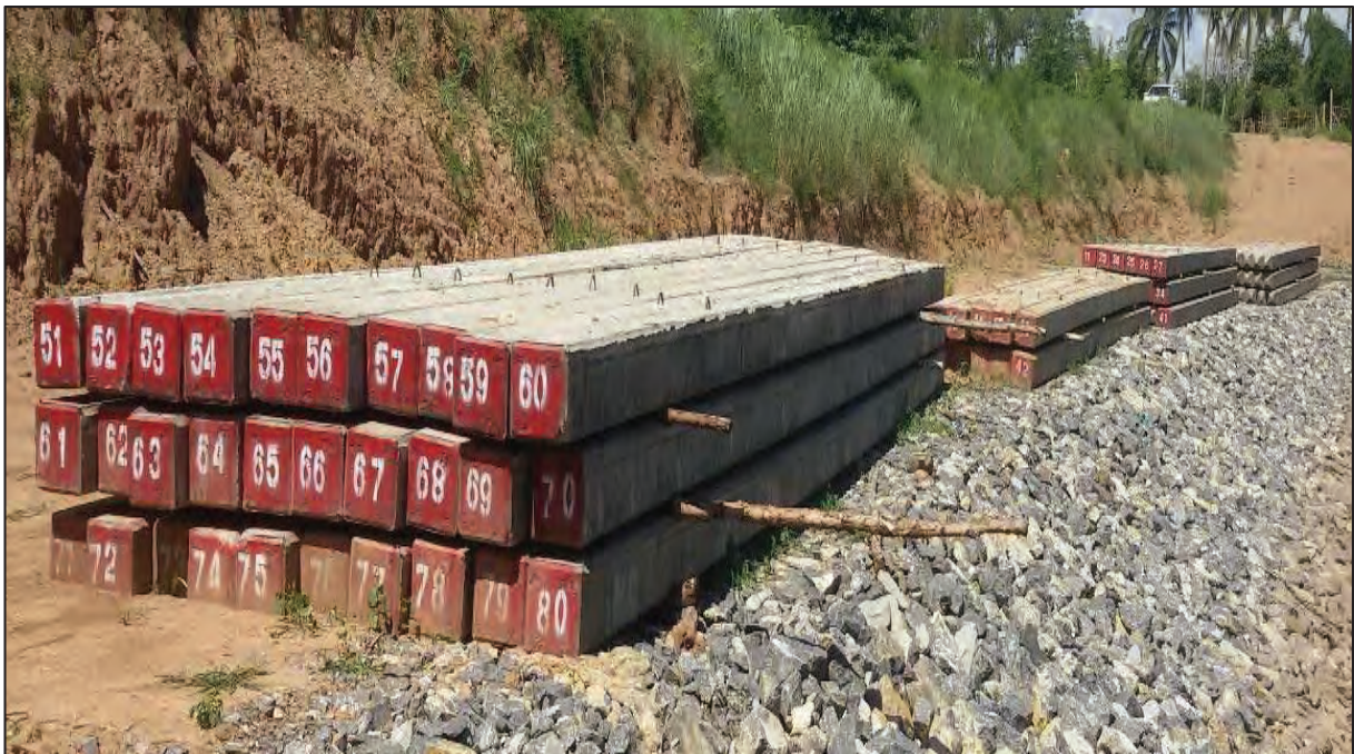
รูปที่ ๔.๑ การเก็บกองเสาเข็มหน้างาน
