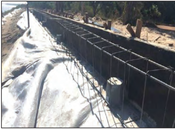
รูปที่ ๒.๒๑.๔ เสริมเหล็กคาน ค.ส.ล.
