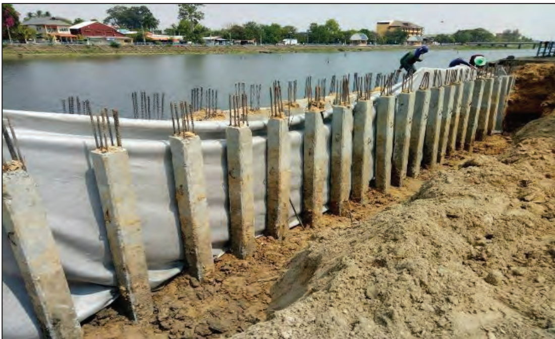
รูปที่ ๒.๔๓ การปูแผ่นใยสังเคราะห์ด้านหลังเขื่อนฯ
