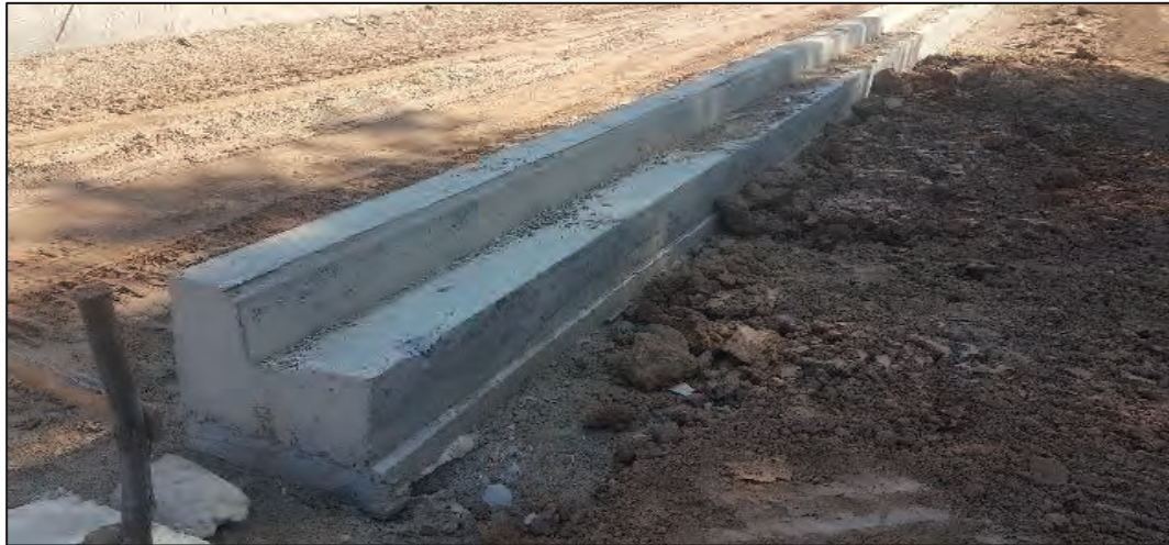
รูปที่ ๔.๒๒ งานเทคอนกรีตโครงสร้าง
