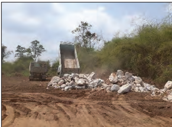
รูปที่ ๔.๔๑ รูปแสดงการนำหินเข้ากอง
