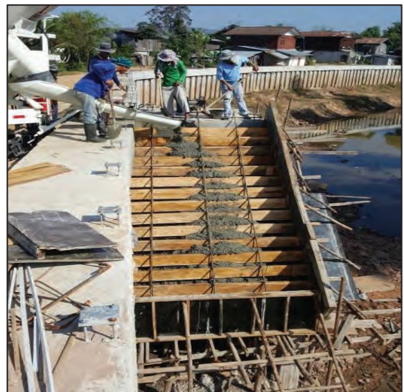
รูปที่ ๔.๑๒ เทคอนกรีตพื้นบันได
