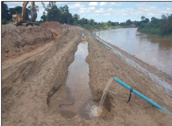
รูปที่ ๔.๔๙ รูปแสดงการนำทรายถมจากกองไปบดอัดบริเวณเขื่อน
