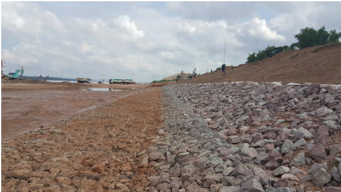
รูปที่ ๒.๔๗.๕ กล่องลวดตาข่ายเมทเทรสบรรจุหินเต็มกล่องติดตั้งที่คันหินทิ้งดินเขื่อน
