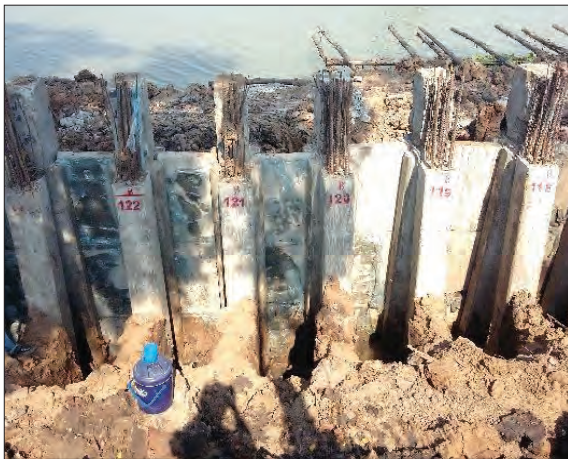
รูปที่ ๔.๖๓ รูปแสดงงานติดตั้งแผงกรู ค.ส.ล.
