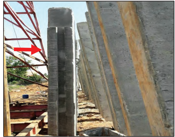
รูปที่ ๒.๑๓ ตอกเสาเข็ม A แนวตั้ง
