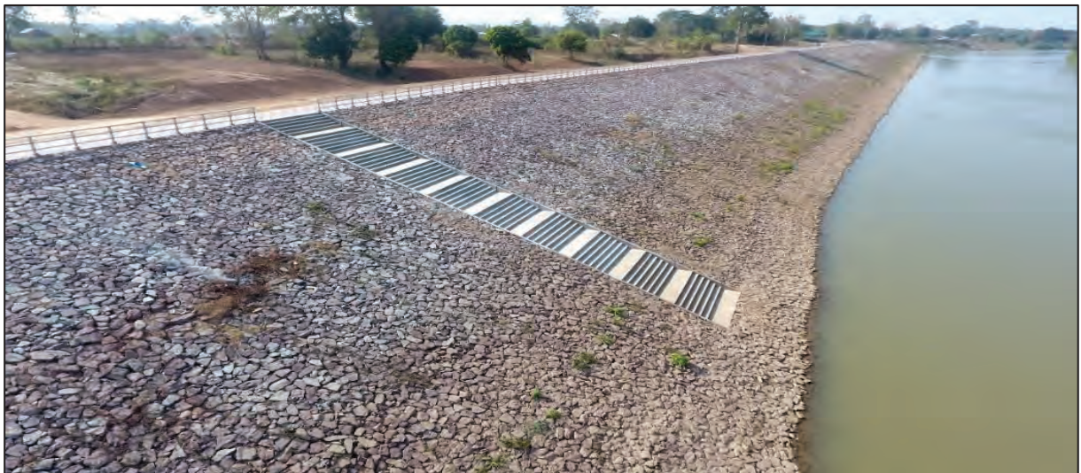
รูปที่ ๒.๑ เขื่อนป้องกันตลิ่งแบบถมทรายเรียงหินหน้าเขื่อน
