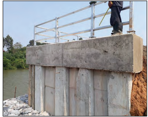
รูปที่ ๒.๑๘ คาน GB๒ อยู่ด้านข้างเขื่อน
